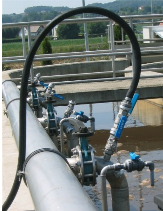
Abbildung 13: Anschlussstutzen zur Einbringung der Reinigungslösung
