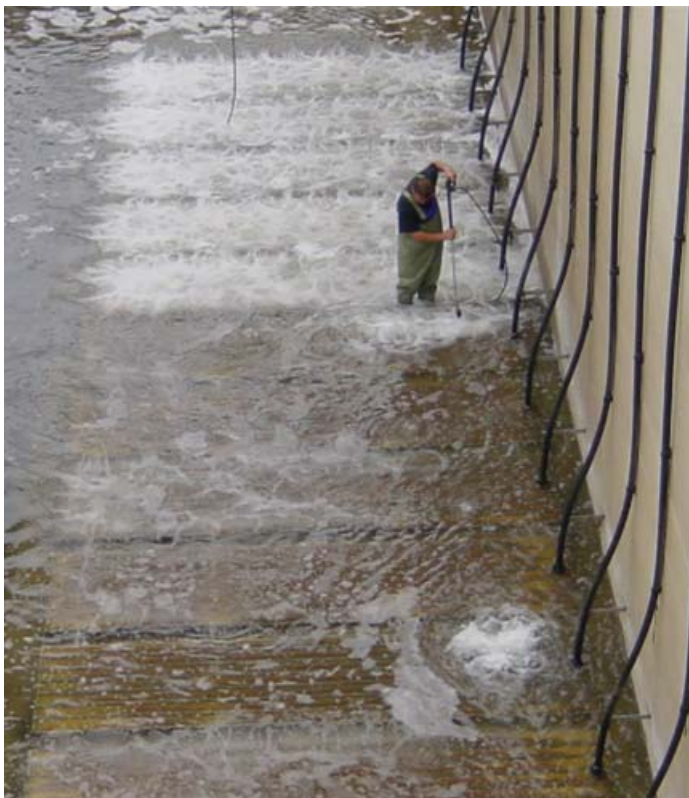
Abbildung 9: Mechanische Reinigung von Belüfterplatten
