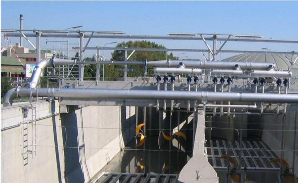
**Abbildung 4:** Luftverteilung Hauptkläranlage Wien Belebungsstufe 2
